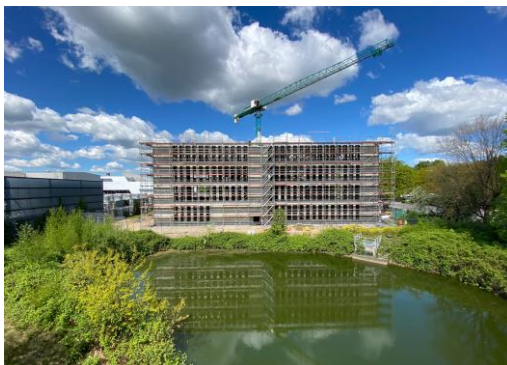
Der Rohbau der „Start-up Labs Bahrenfeld“ auf dem DESY-Campus.
