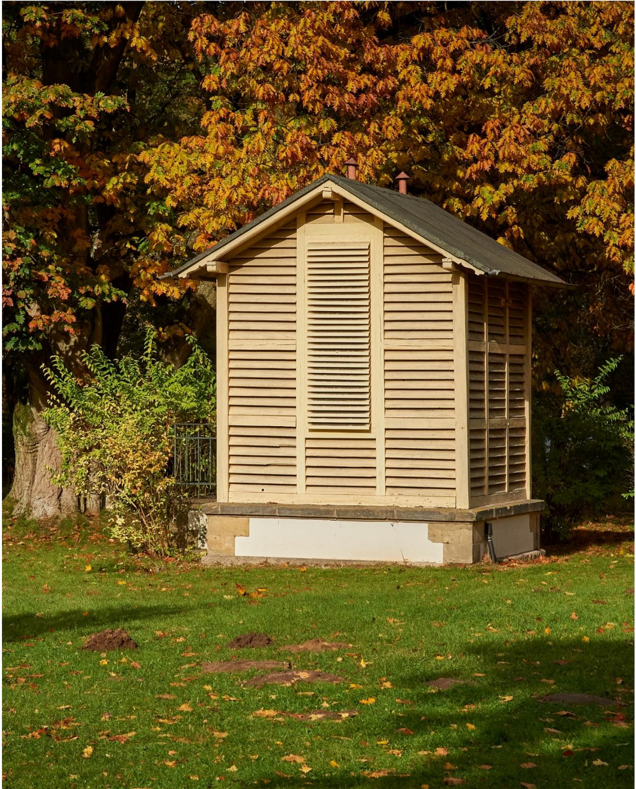
Abb. 7: Das Mirenhäuschen (B6) von 1910 ist ein schlichter Holzbau, der eine außergewöhnliche Stellung einnimmt: Die Mire diente mit Hilfe von Quecksilberhorizont und Umlenkspiegel der Eichung des Meridiankreises. Foto: Michaela Becker, Oktober 2021
