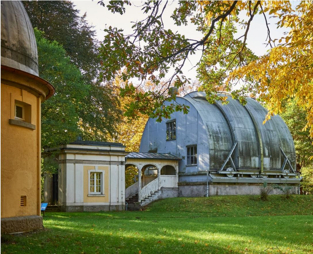
Abb. 4: Gebäude für den Meridiankreis (B1) mit laubenartigem Übergang aus Holz zum Portalvorbau des Dienstraums. Das Tonnendach kann in Nord-Süd-Richtung auf 3m Breite geöffnet werden. Stahlkonstruktion (1907–09), seit 1967 leerstehend, Instandsetzung 2000/03, 2010–12. Foto: Michaela Becker, Oktober 2021
